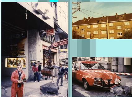
*Chute de cheminées et de parements lors du séisme de Liège en 1983*
